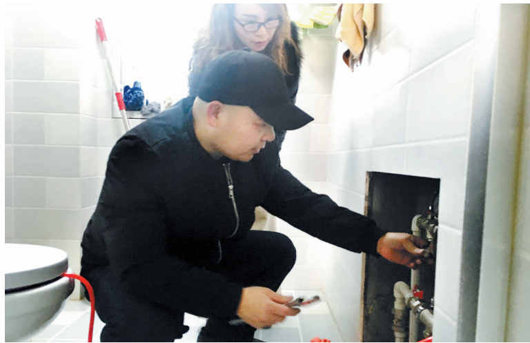
吴朝阳帮业主检修暖气设备
