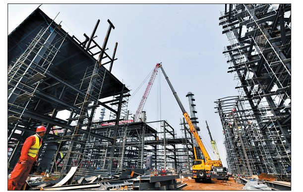
洛阳宏兴新能工业三苯项目建设现场
