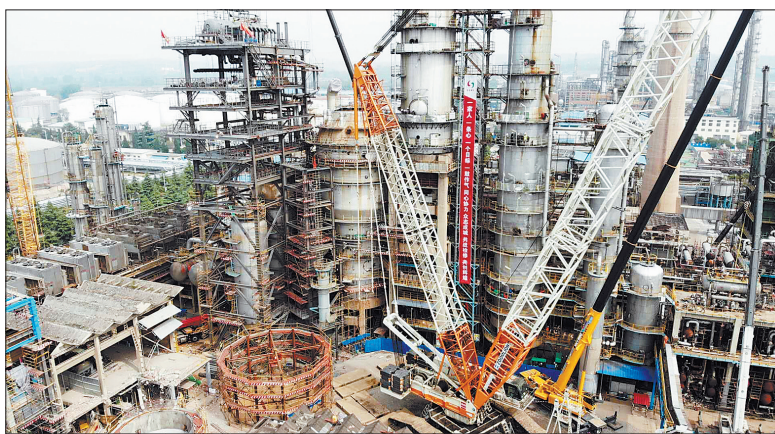
一号催化裂化装置改造施工现场
