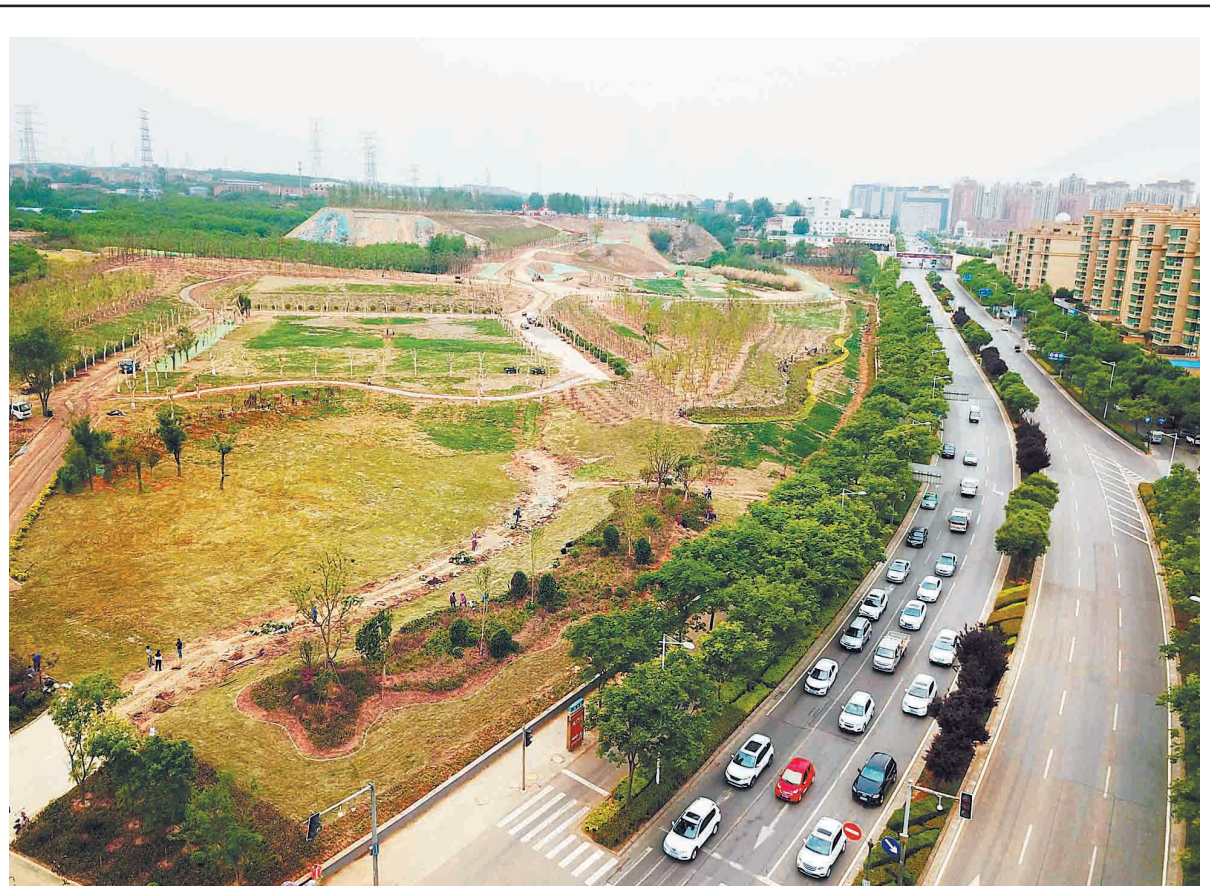
近日，在高新区周山森林公园东大门建设现场，园林职工正在加紧进行绿化，预计10月底，周山森林公园除了原有的南出入口、西出入口，东出入口也将建成投用，为人们游园提供便利。
