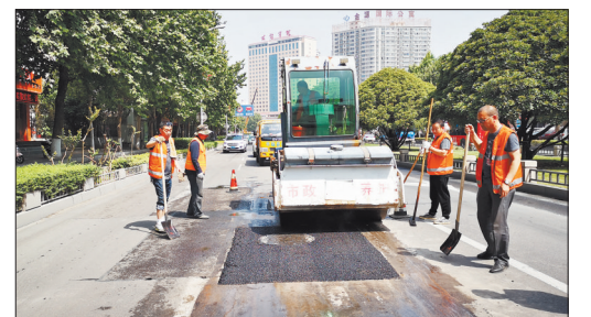
养护人员正在南昌路修补病害窞井盖
