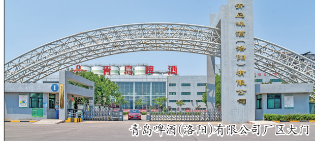
青岛啤酒(洛阳)有限公司厂区大门
