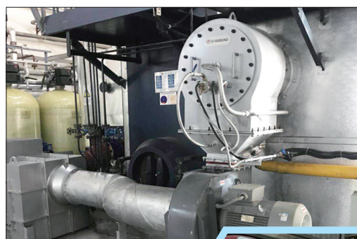
河南花花牛乳业改造项目现场
