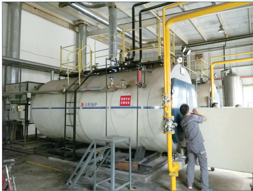
中车洛阳机车有限公司改造项目现场
