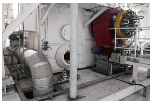
郑州市热力总公司改造项目现场
