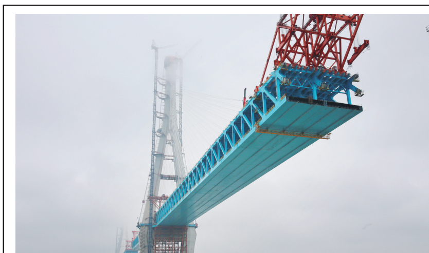
世界最大跨度公铁两用斜拉桥主塔顺利封顶
