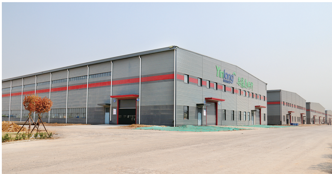
银隆(洛阳)新能源汽车整车生产制造基地一角
