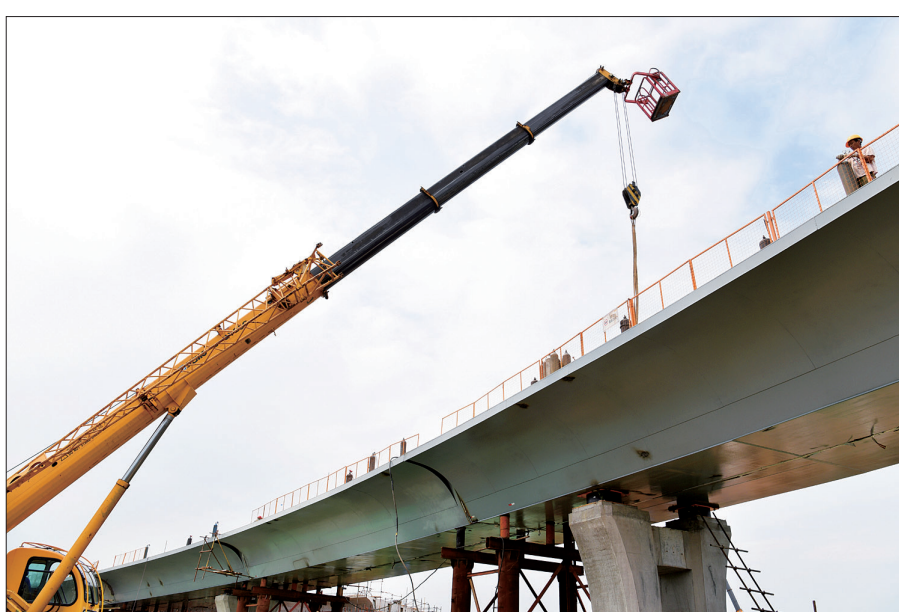
甘泉河站互通立交施工现场 记者 梅占国 摄
