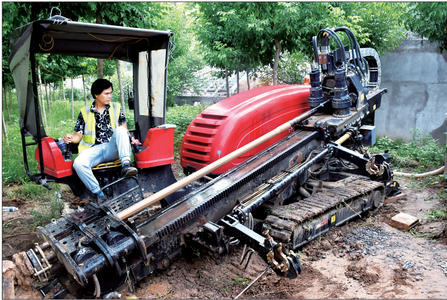
崔河村非开挖顶管施工现场 王祝鹏 摄
