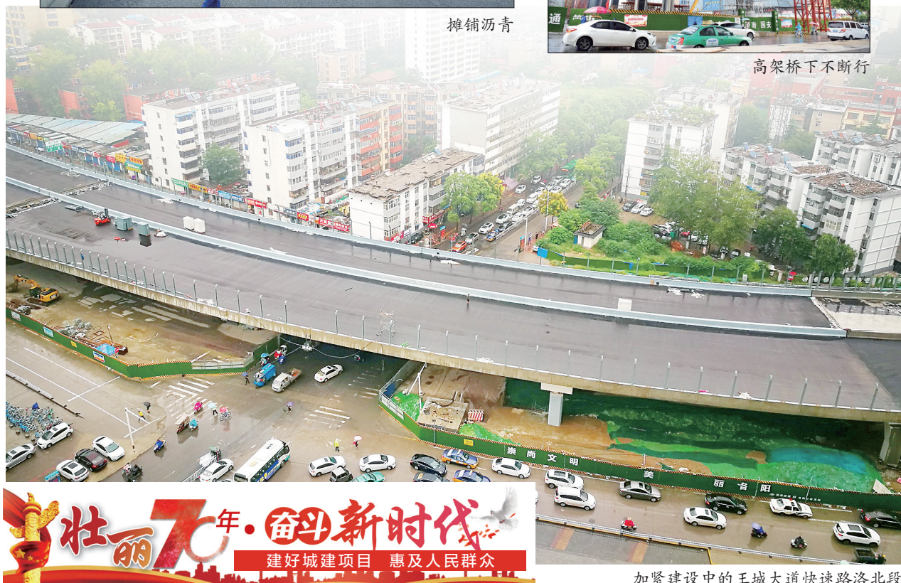
加紧建设中的王城大道快速路洛北段
