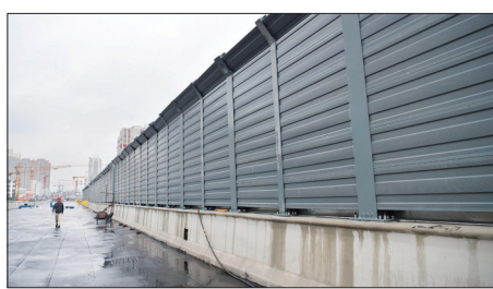
道路隔音屏障
