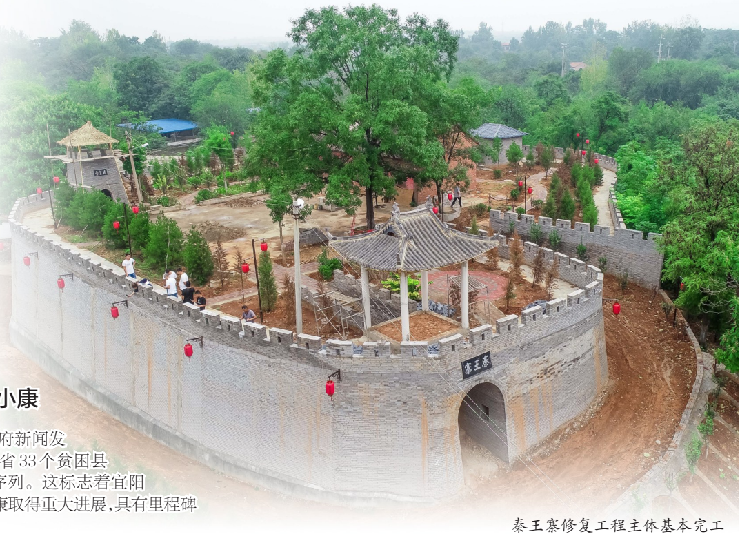
秦王寨修复工程主体基本完工
