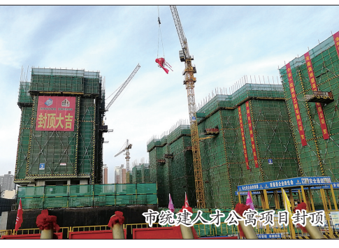
市统建人才公寓项目封顶
