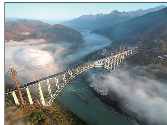
大瑞铁路怒江特大桥主体建成
