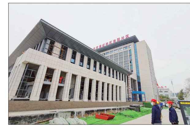
自贸区洛阳片区综合服务中心项目现场
