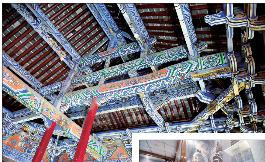
▲大殿内部梁架结构 ▶雕像展厅
