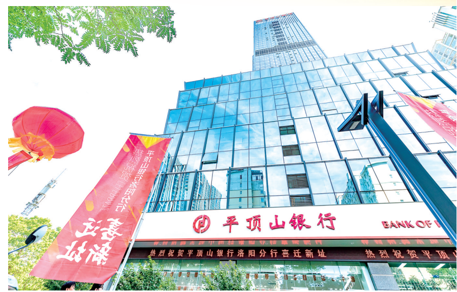
平顶山银行洛阳分行乔迁新址
