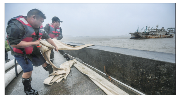
抢险人员在进行排水抢险(新华社发)
