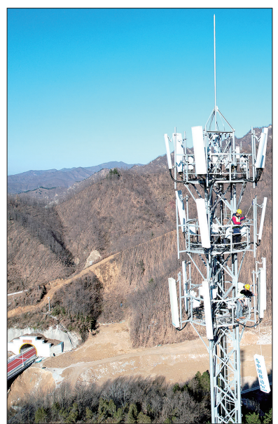
移动公司工作人员在吊装基站
