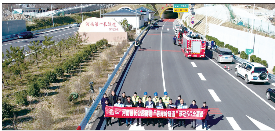
老界岭隧道实现移动5G全覆盖
