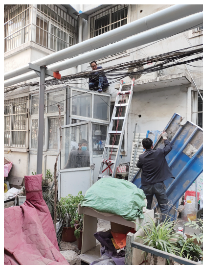
老城区某小区整治私搭乱建现场
