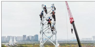
昨日,在位于伊滨区的220千伏汉飞线铁塔组立现场,国网洛阳供电公司施工人员进行高空作业。该输电线路工程起于伊滨区的汉都变电站,至于洛龙区的飞跃变电站,将进一步完善洛龙区、伊滨区电力主网架,确保洛南电网的安全可靠运行。洛报融媒首席记者 李卫超 摄
