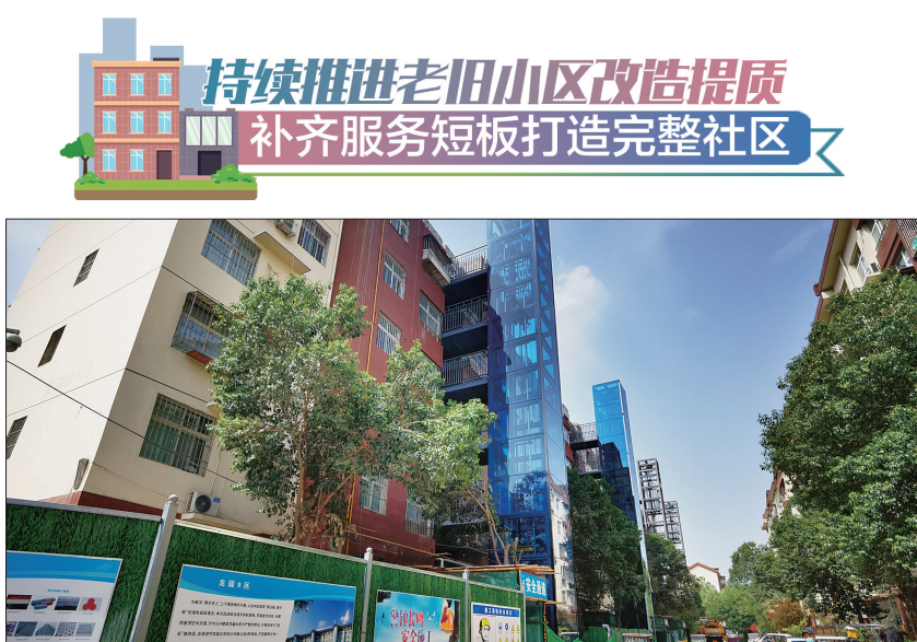
龙瑞B区正在加装电梯
