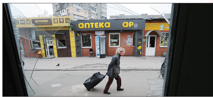
4月19日,在马里乌波尔,当地居民从被损坏的建筑旁走过(新华社发)
