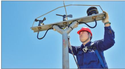
检查位于风机机舱顶部的超声波风速、风向仪
