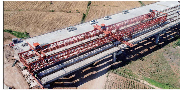
建设中的永定河大桥
