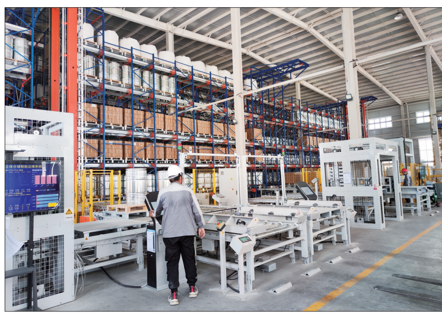
洛阳建龙吸附材料产业园智能仓库
