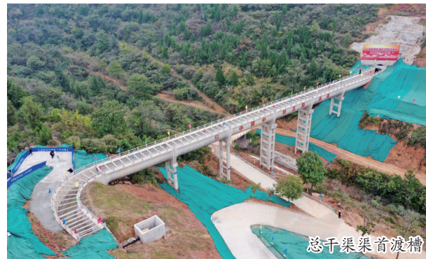
总干渠渠首渡槽
