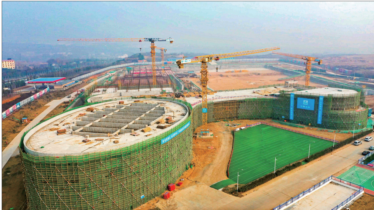
项目现场建设正酣
