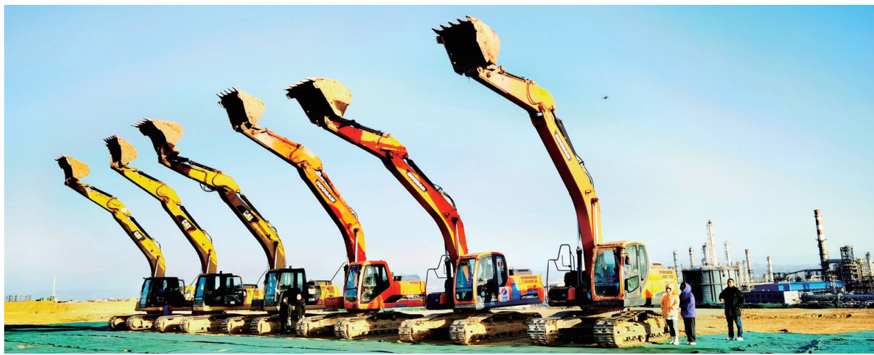
黎明化工院专用新材料项目开工现场
