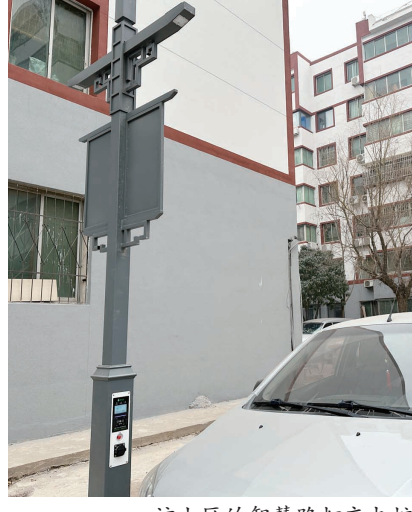
该小区的智慧路灯充电桩
