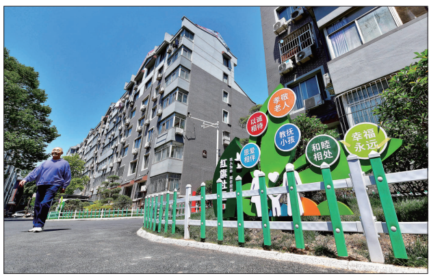
老旧小区换新颜,居民生活享便利(资料图片)
