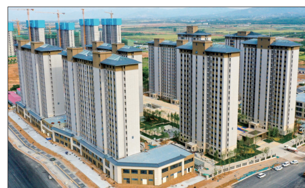
伊滨区人才公寓项目建设加快收尾
