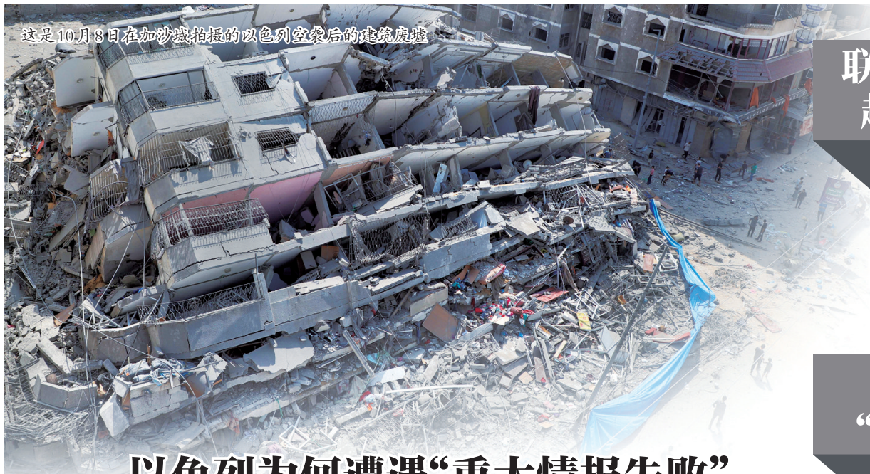
这是10月8日在加沙城拍摄的以色列空袭后的建筑废墟。
