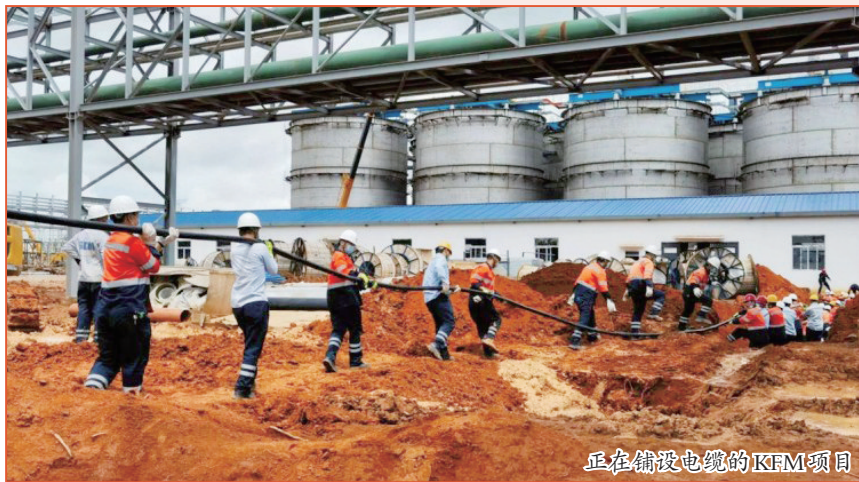
正在铺设电缆的KFM项目
