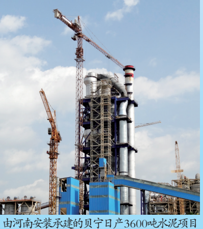
由河南安装承建的贝宁日产3600吨水泥项目
