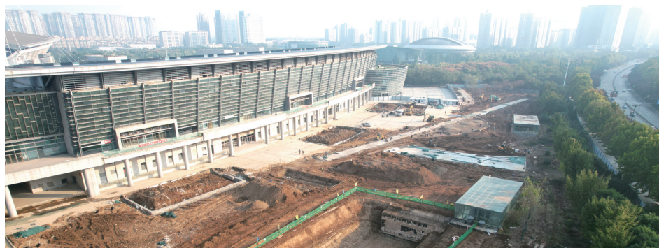
城市文化客厅项目室外工程加紧施工
