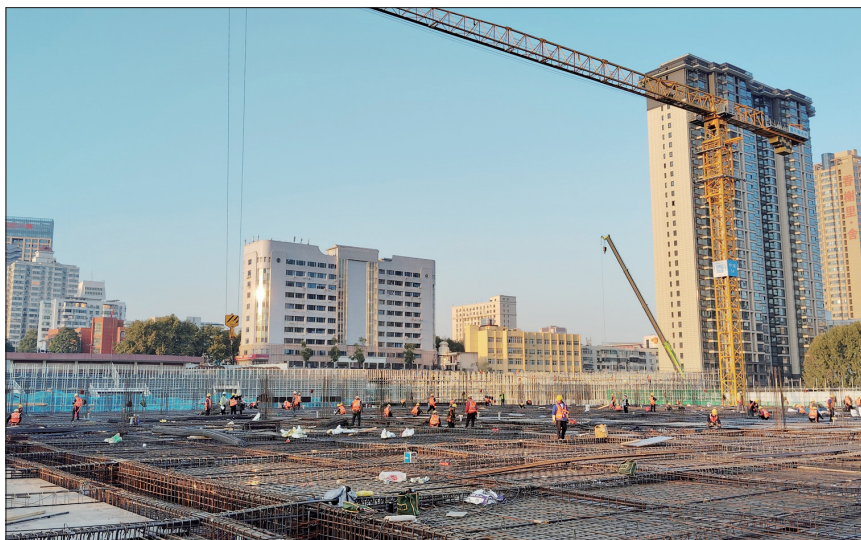
项目施工现场
