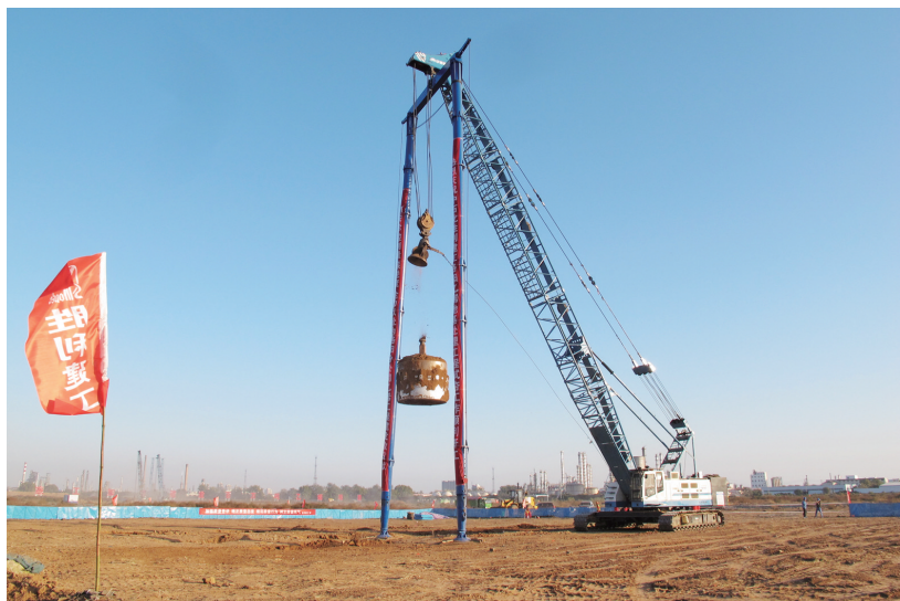
地基试夯工程现场
