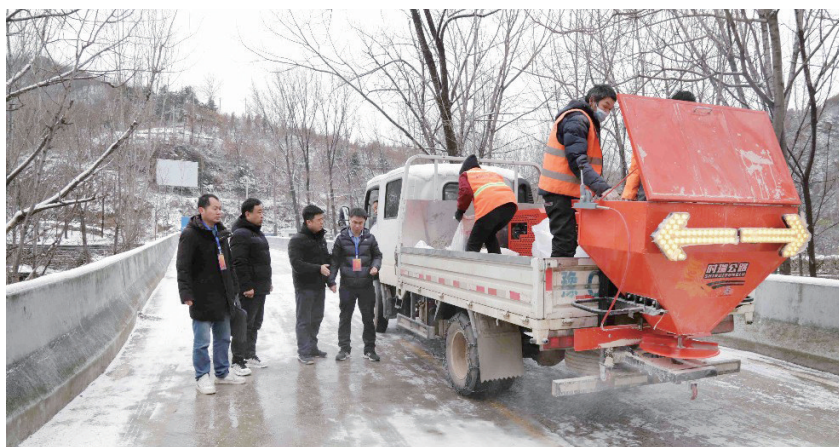
汝阳县纪检监察干部在三屯镇龙王庄桥开展监督检查,确保公路安全畅通
