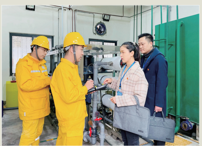
近日,偃师区纪委监委联合有关部门深入供热企业实地走访、现场查看,对供热设施设备运行情况进行监督检查,督促解决用户室内温度不达标、供热时长不够等问题。王雷 王莎莎 摄
