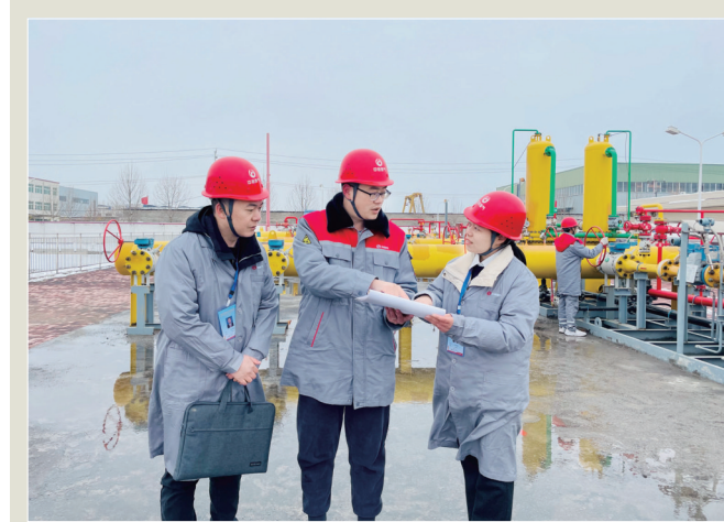
近日,偃师区纪检监察干部在偃师中裕燃气有限公司管道检修现场监督检查。该区纪委监委与城镇燃气安全专项整治工作专班紧密协作,紧盯安全生产责任落实、隐患排查责任落实等方面加强监督检查,助力护民生、保安全。王雷 王莎莎 摄
