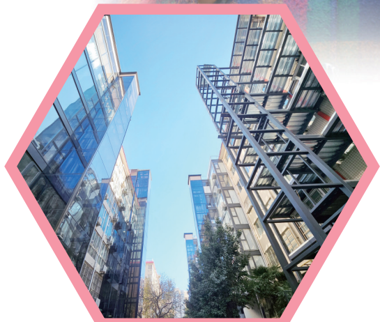
置隆花园小区已加装多部电梯
