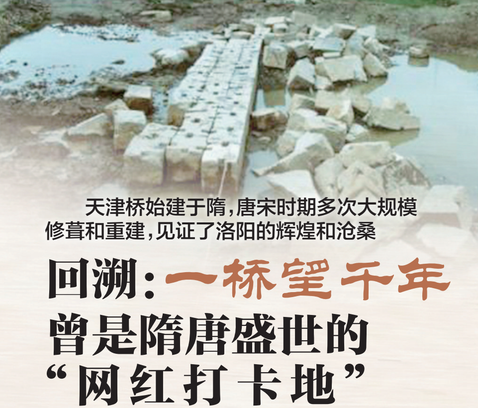
2号桥墩遗址(本组图片均为资料图片)
