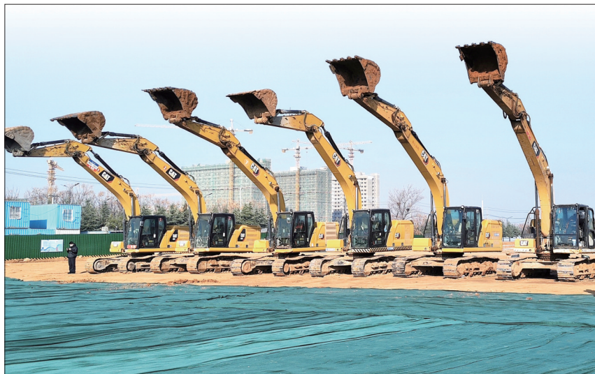
洛阳新能源产业园开工建设
