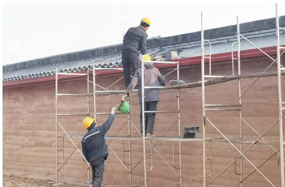
施工现场一派火热景象 ▲工匠师傅在建设坊墙
