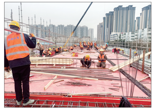
施工人员有序作业
