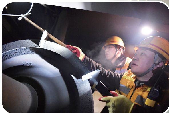
国铁集团郑州局郑州工务机械段作业人员对车辆进行环车检查
