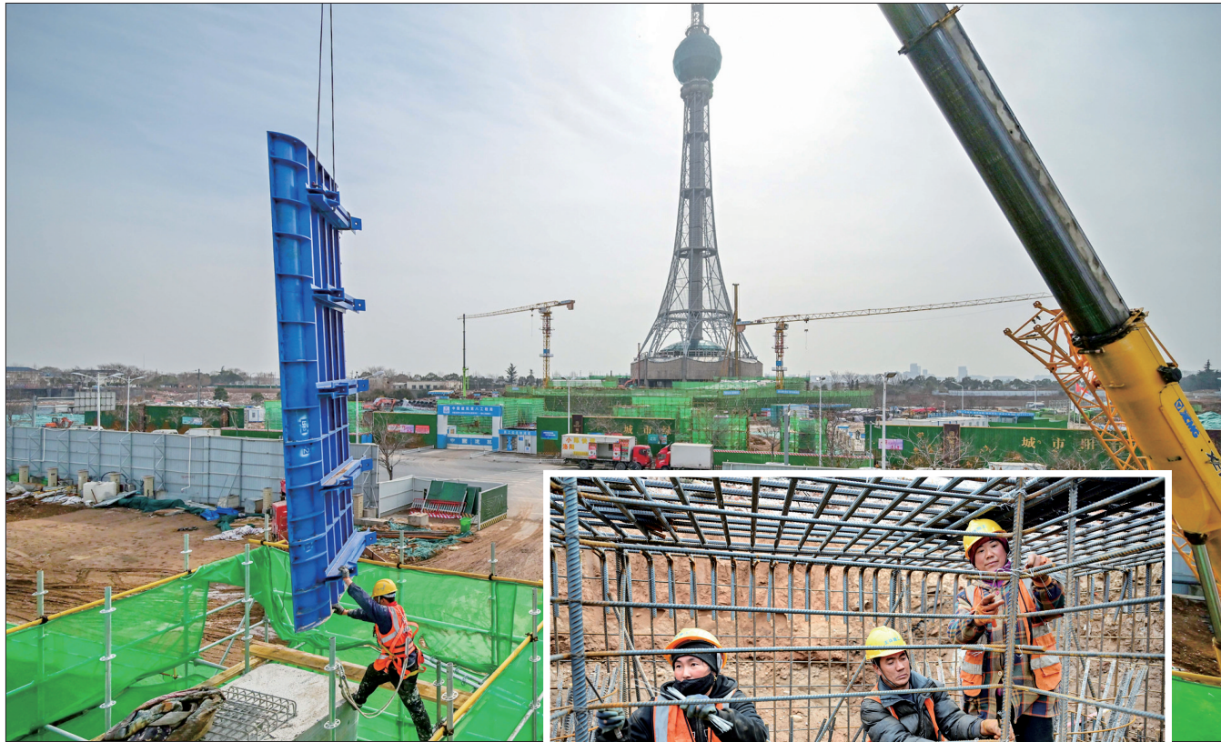
16日,在洛阳城市阳台项目一期施工现场,工人正加紧施工 洛报融媒记者 李卫超 通讯员 朱江 摄
