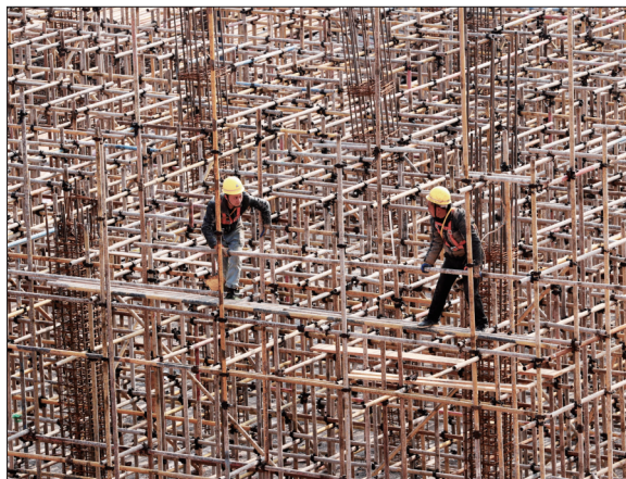
中铁八局的工人在渝湘高铁重庆黔江段黔江站综合交通枢纽工程施工
