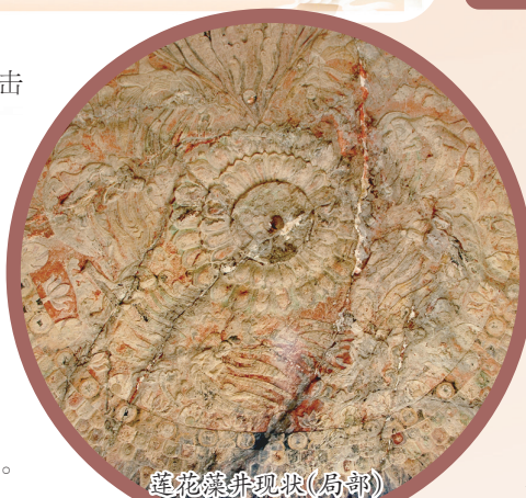
莲花藻井现状(局部)
